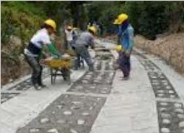
Mantenimiento de cunetas, para darle un correcto drenaje y escurrentía de las aguas pluviales.
