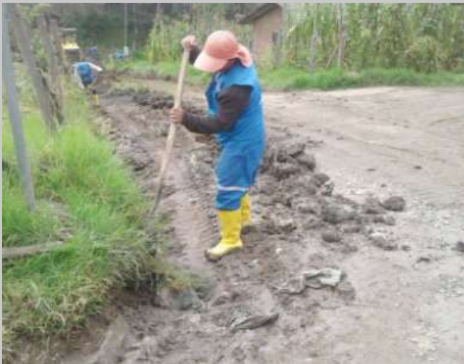
Mantenimiento de cunetas, para darle un correcto drenaje y escurrentía de las aguas pluviales.
