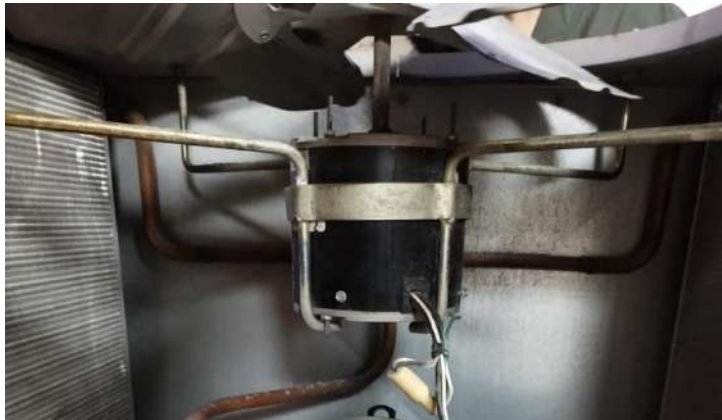
Figura 7. Motor desalineado
